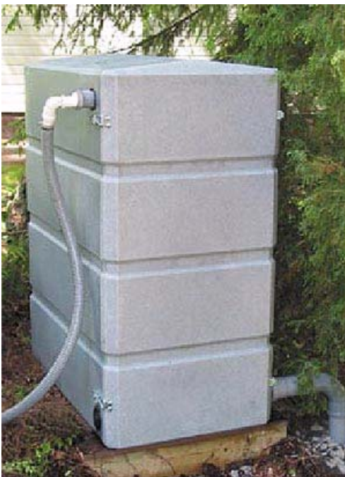
Kuva 5. Harmaavesi suodatin (Biolan).
