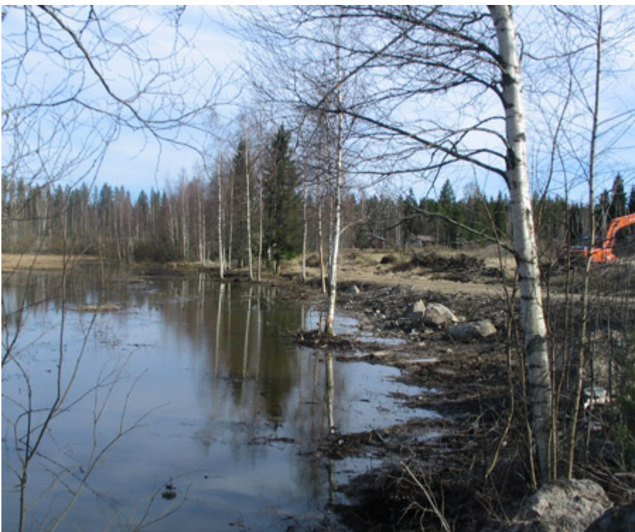
... ja tässä risukkomättäät on kuopaistu pois kaivinkoneella
